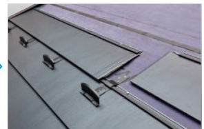
4 雪止め金具の取り付けと 本体接合部
